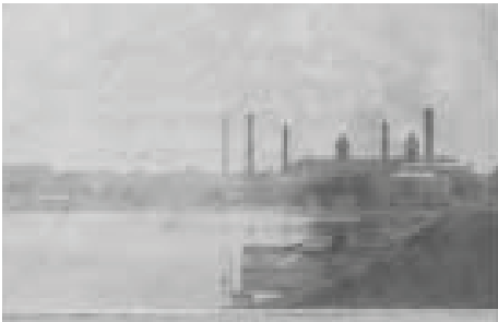
Ilustração 3 – “Detroit (MI) – A água do lago é apenas tratada pelo cloro. Reservatório para água purificada e casa das bombas”. Imagens feita durante as visitas técnicas de Geraldo Horácio aos sistemas de abastecimento nos Estados Unidos, 1918-1920. Fonte: Arquivo Pessoal de Ada Celina Paula Souza de Anhaia Mello.
